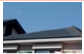
E様 発電所
