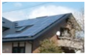
社長宅 発電所
