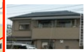
S様 発電所
